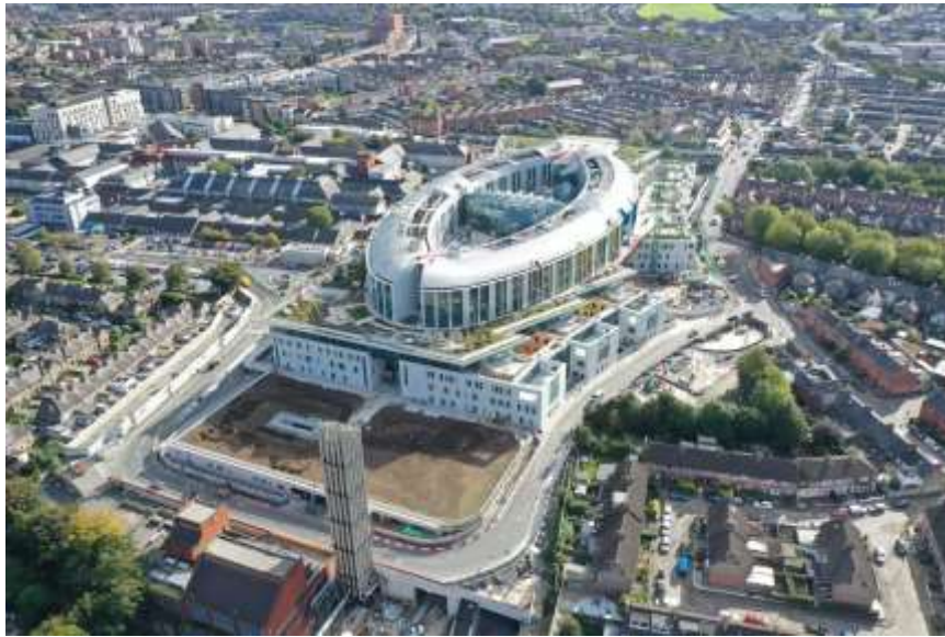
(Instalaciones del hospital)
