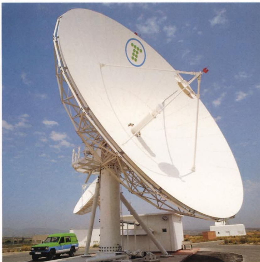
Detalle del complejo de Comunicaciones por Satélite del Penedés.
