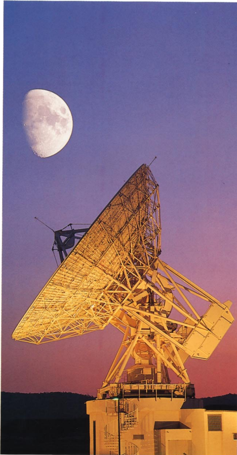
Antena de la Estación terrena de Amuñía de Tajuña.
