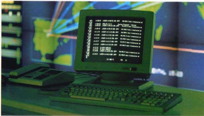
Centro de Gestión Dinámica de Red de la central internacional de Alcobendas, Madrid.
