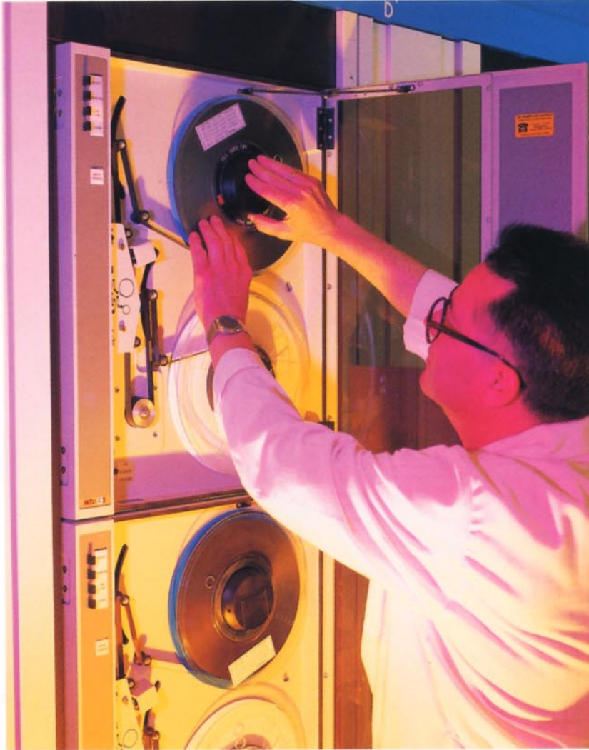
Labor de control en la central digital de Cartuja-Sevilla.
