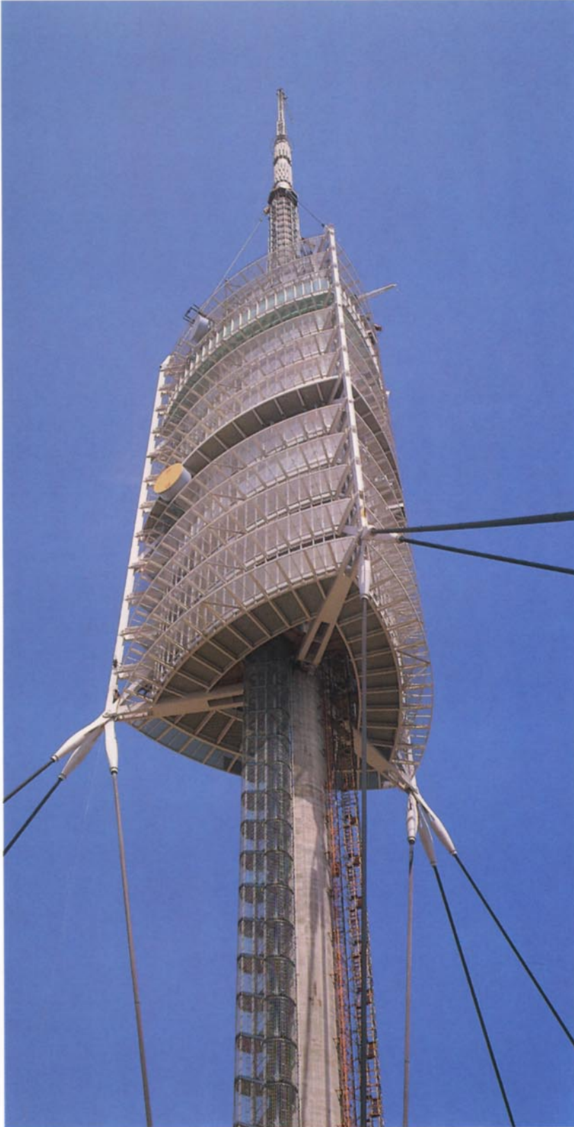
Detalle de la Torre de Comunicaciones de Collserola, Barcelona.
