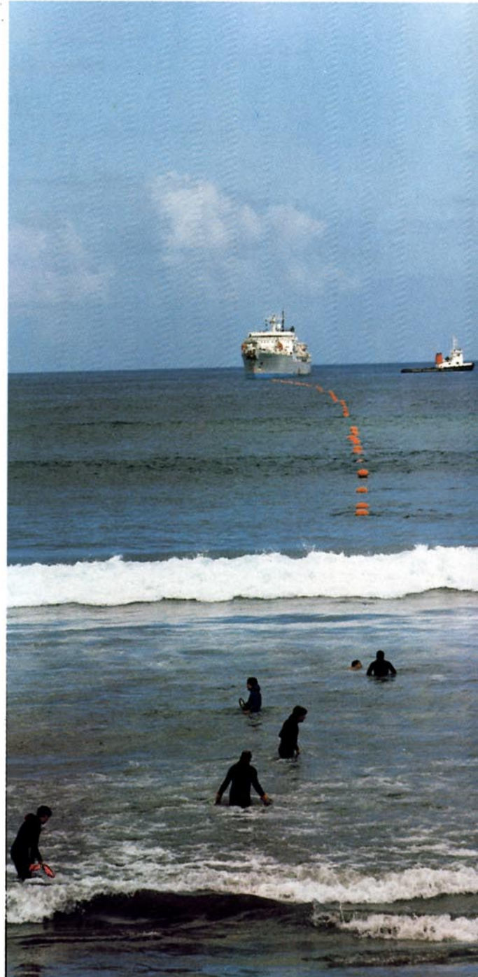
Momento del tendido del cable submarino de fibra óptica OPTICAN, entre Tenerife y Gran Canaria.
