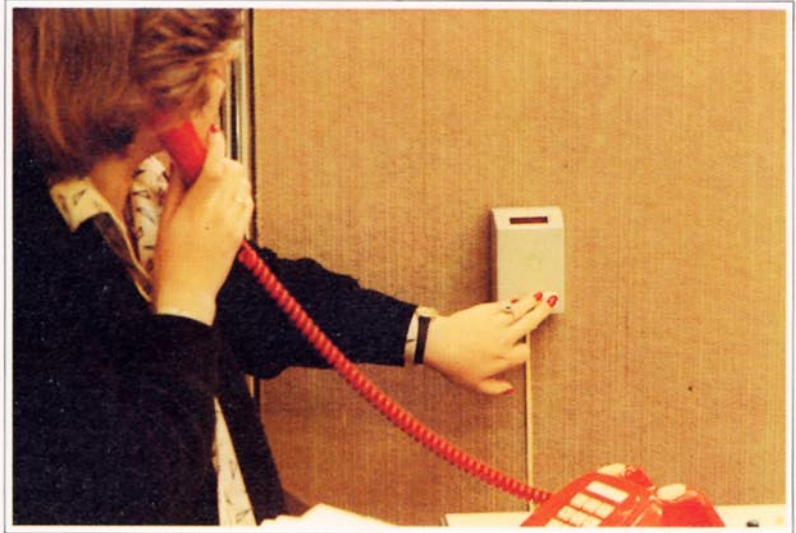
Nuevo contador domiciliario.
