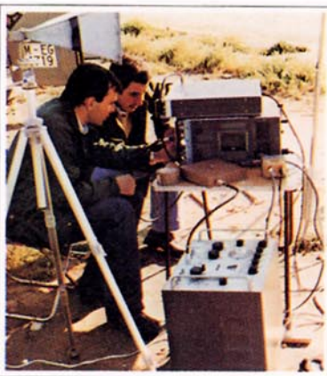
Trabajos en Armuña de Toluca (Guadalajara), en cuyo término municipal será instalada una nueva Estación de Comunicaciones por Satélite.
