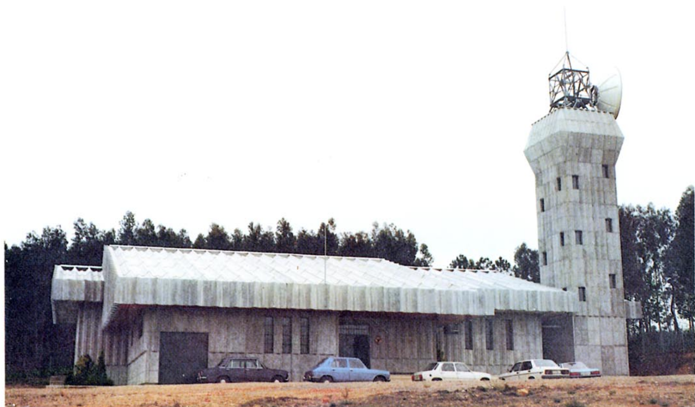
Estación terminal en Rodiles (Asturias) del cable submarino España-Reino Unido III.
