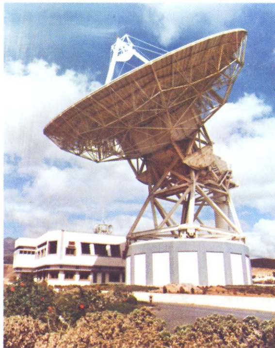
Estación Terrana de Comunicaciones por Satélite de Agüimes (Las Palmas).
