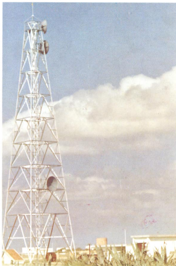
Antena para enlace con cable submarino (Conil).
