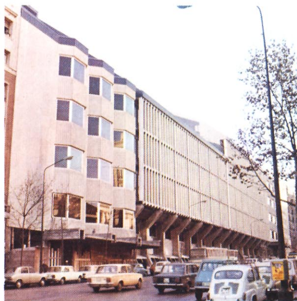
Central en construcción de Rios Rosas (Madrid).
