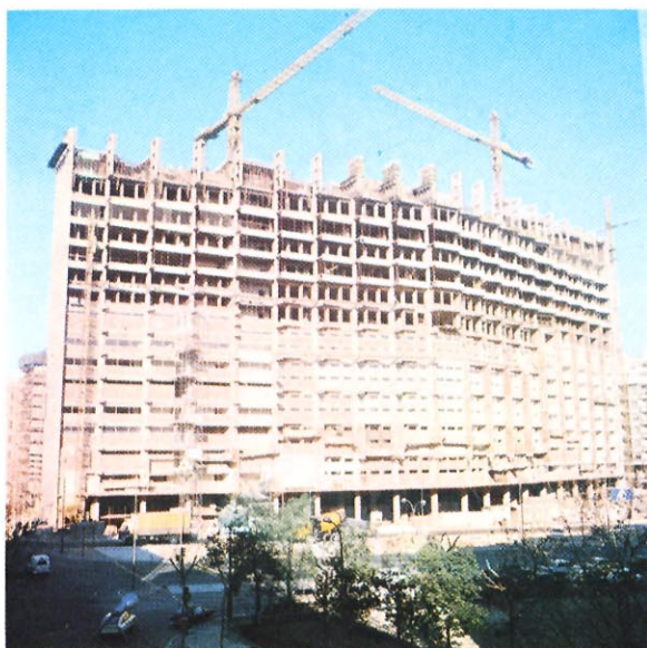
Central en construcción Estel (Barcelona).
