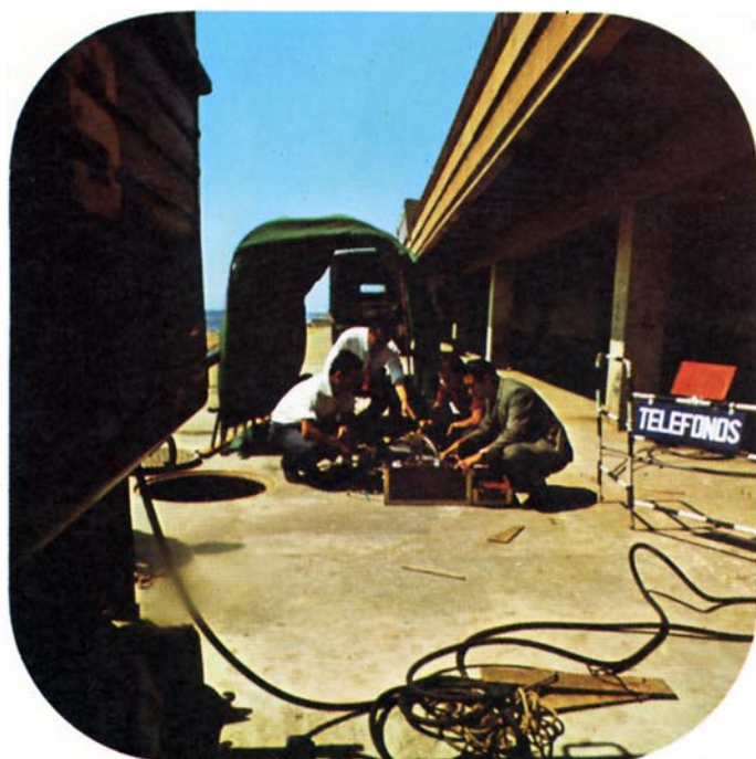
Comprobaciones en tierra del cable submarino.
