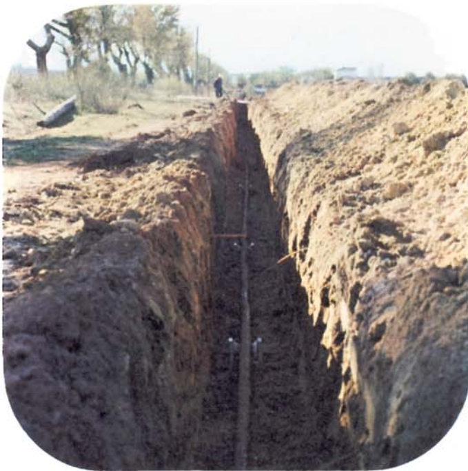
Tendido de cable coaxial.
