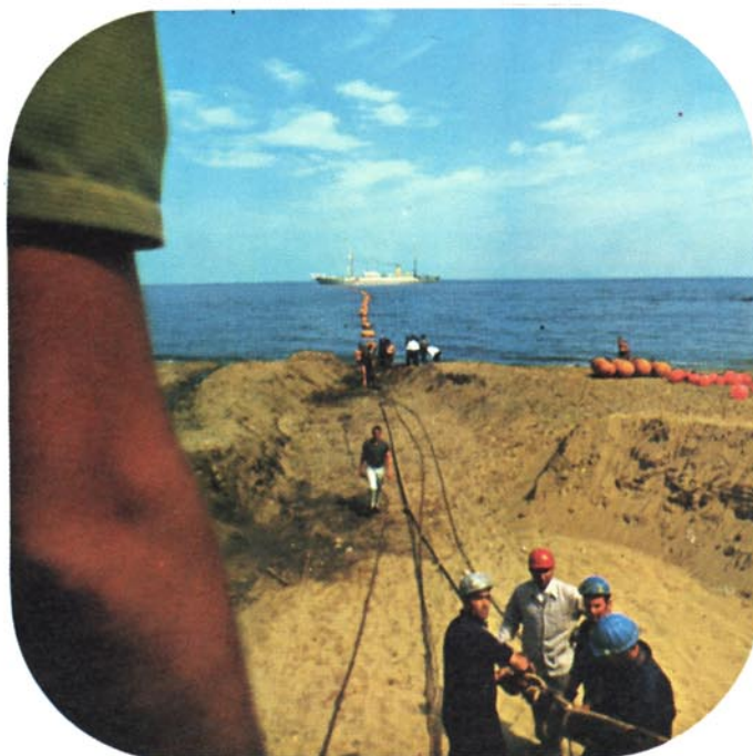
Operaciones en tierra para el tendido del cable submarino.
