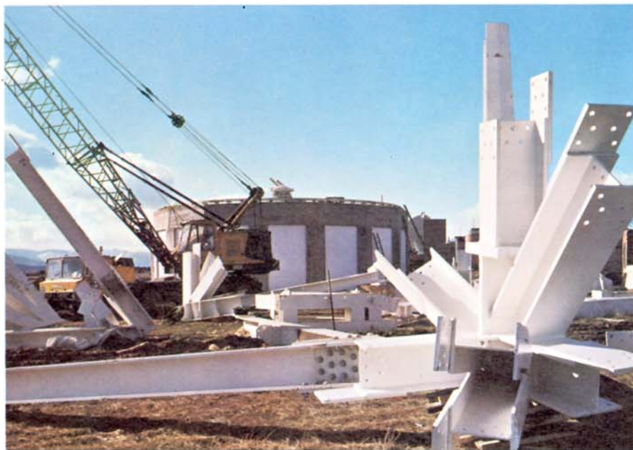
Construcción de la base de la segunda Estación de Buitrago.
