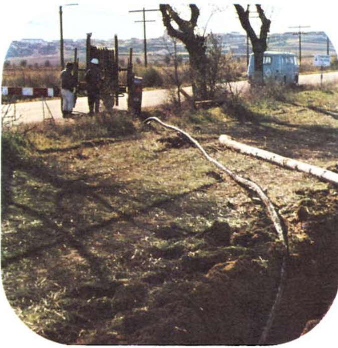
Obras de tendido de cables.
