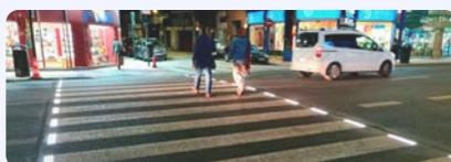
Despliegue de 5 pasos de peatones inteligentes en las principales arterias de Murcia. Incluyen sensores capaces de detectar a los viandantes que van a cruzar para que se active la señalización luminosa vertical y horizontal incrustada en el pavimento, avisando a los vehículos.
