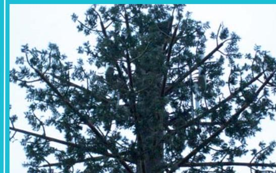
Ejemplo de torre de comunicación móvil camuflada bajo estructura que simula vegetación.
